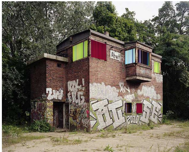
Standort Gleisstellwerk Anhalter Bahnhof
